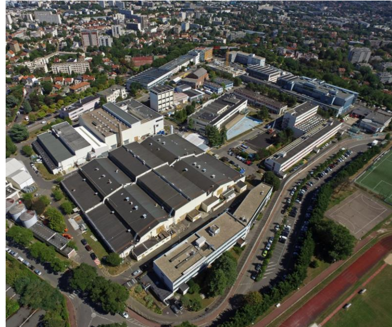
Vue aérienne du CEA/Fontenay-aux-Roses.
